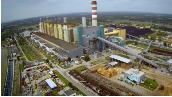
Elektrownia Polaniec – Enea
